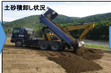
土砂敷均し状況
