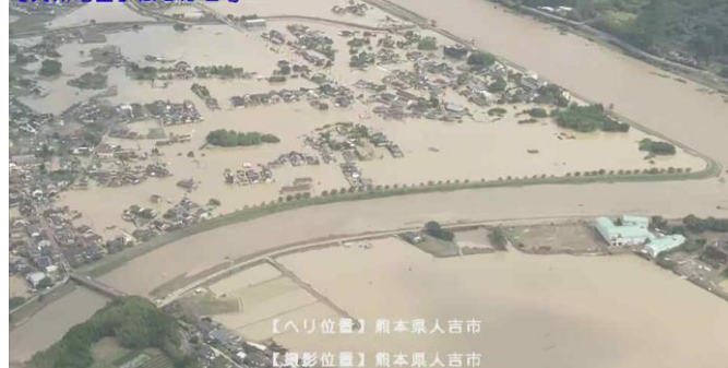
人吉市街部における浸水状況(7月4日)
