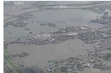
筑後川水系筑後川 (福岡県久留米市)
