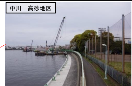
堤防の耐震対策
