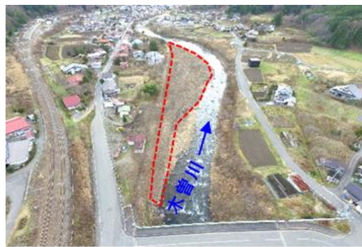
河道掘削・樹木伐採後(R2.8撮影)
