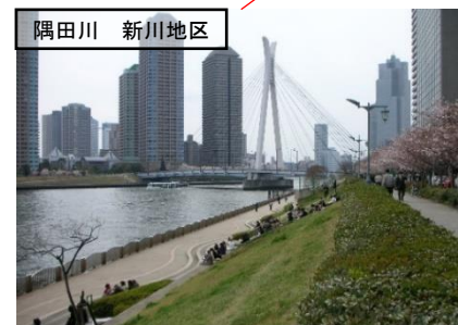
都によるスーパー堤防の整備
