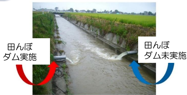
排水状況の比較 平成23年7月新潟・福島豪雨 白根郷地区(新潟市)
