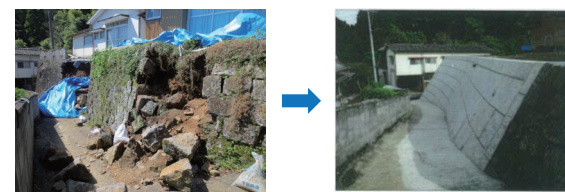
平成28年熊本地震の特例措置事例
