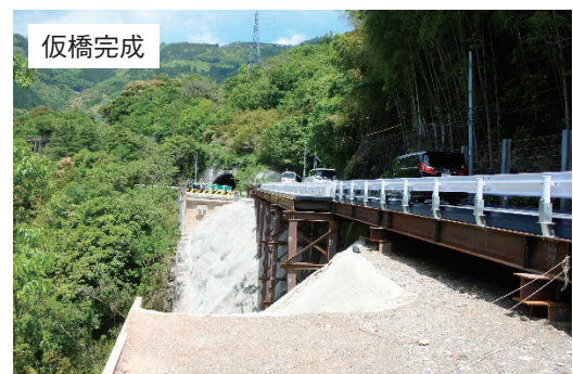
図-3 仮橋設置前後の状況
