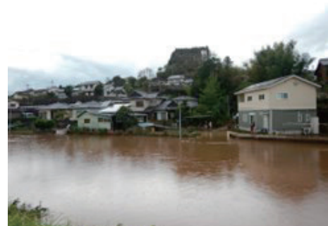
五ヶ瀬川沿川の内水による浸水状況 (宮崎県延岡市)
