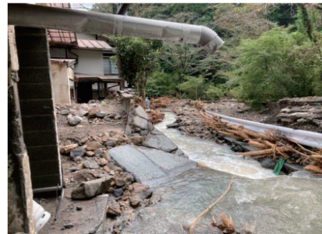
静岡県静岡市 葵区油山で発生した土石流等 (静岡県静岡市葵区)
