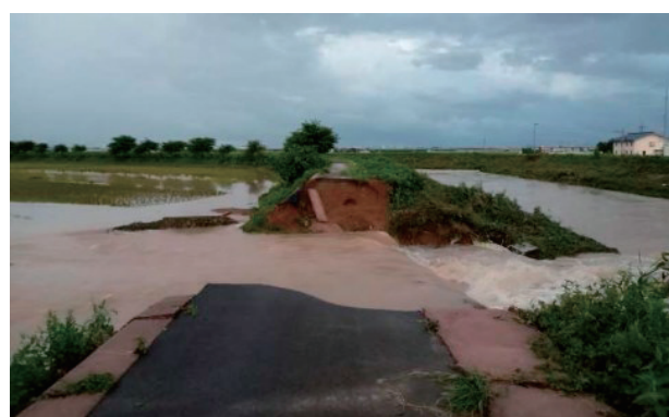
梯川水系 鍋谷川 なべたに の堤防決壊 さか （石川県小松市 かほし ）
