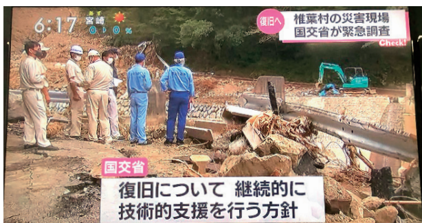
図-2 災害緊急調査の様子 (TV 報道)
