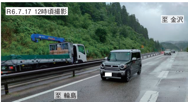
写真① 穴水IC付近
