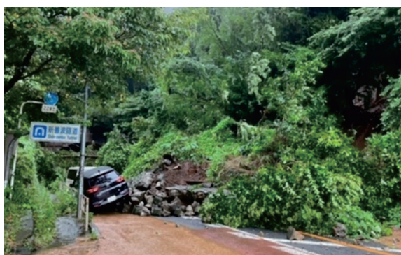
写真-1 国道246号の被災（提供 横浜国道事務所）
