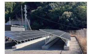
太陽光発電施設の設置
